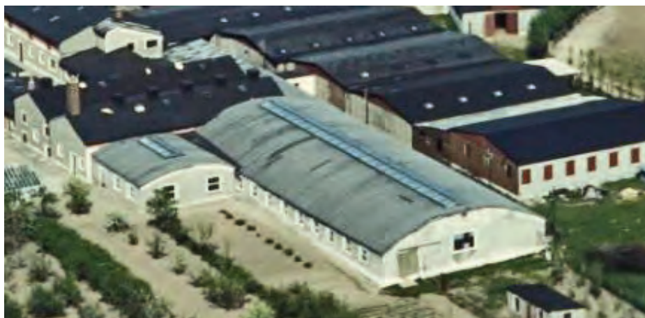
Den store hal med væveriet og barakkerne omkring. Billedet er taget i 1956 af Sylvest Jensen, Hillerød.
