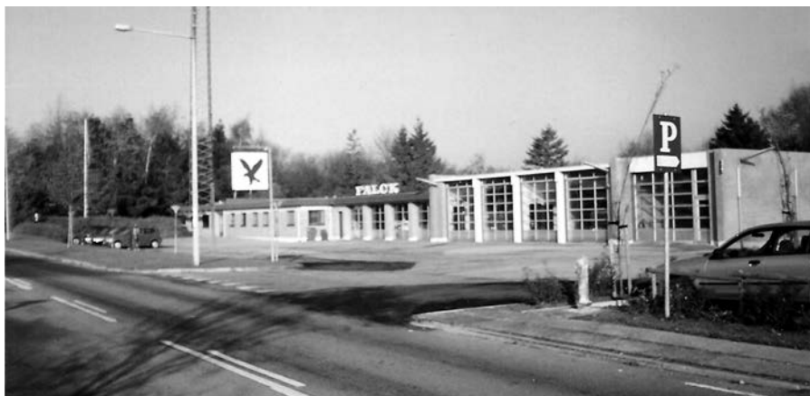
Stationen i midten eller sidst i 80'erne, der er tilbygget vagtcentral og vaskehal.
